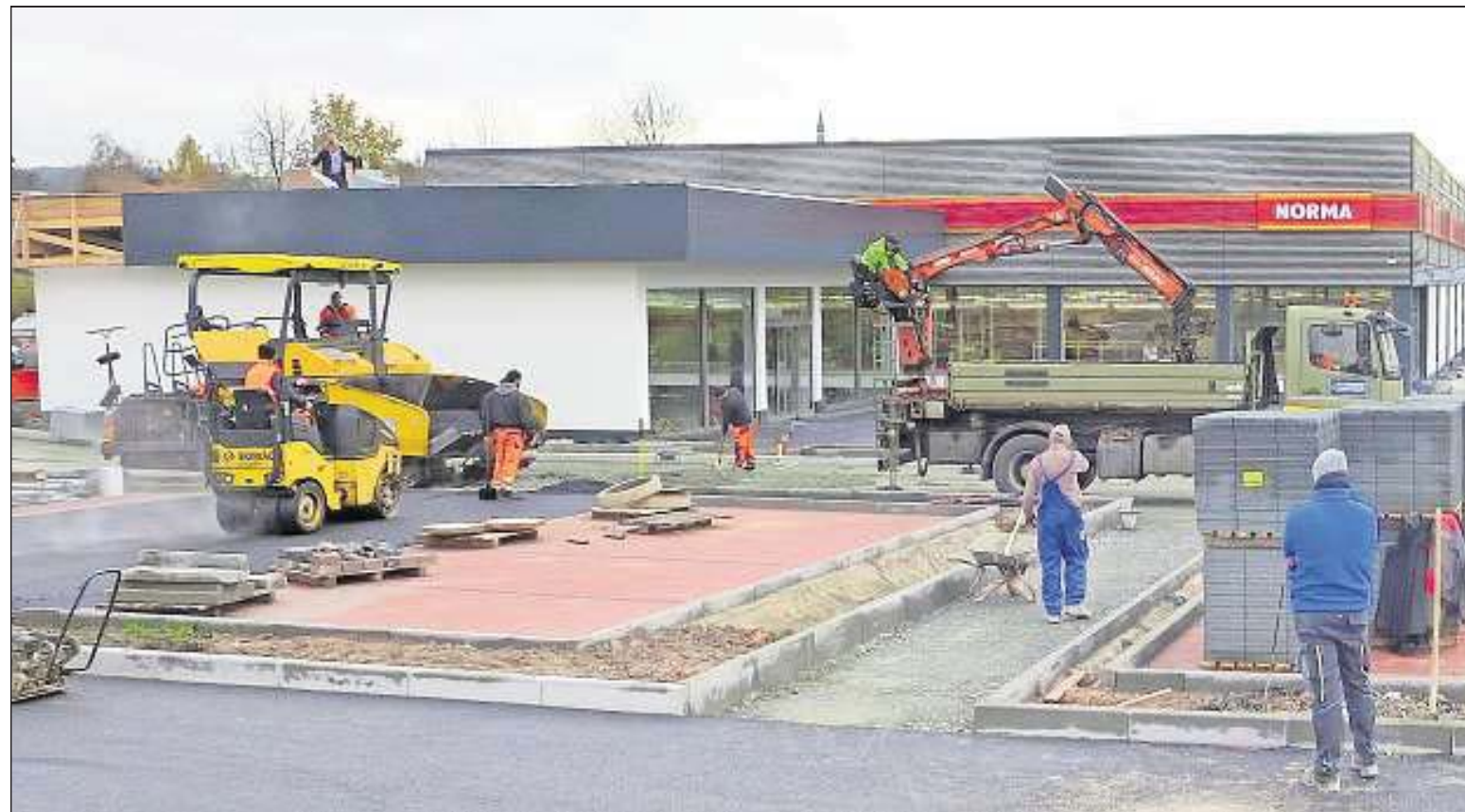
Vor der Fertigstellung: An den Außenanlagen beim Norma-Discounter auf dem Weidenberger Untermarkt wird intensiv gearbeitet.
