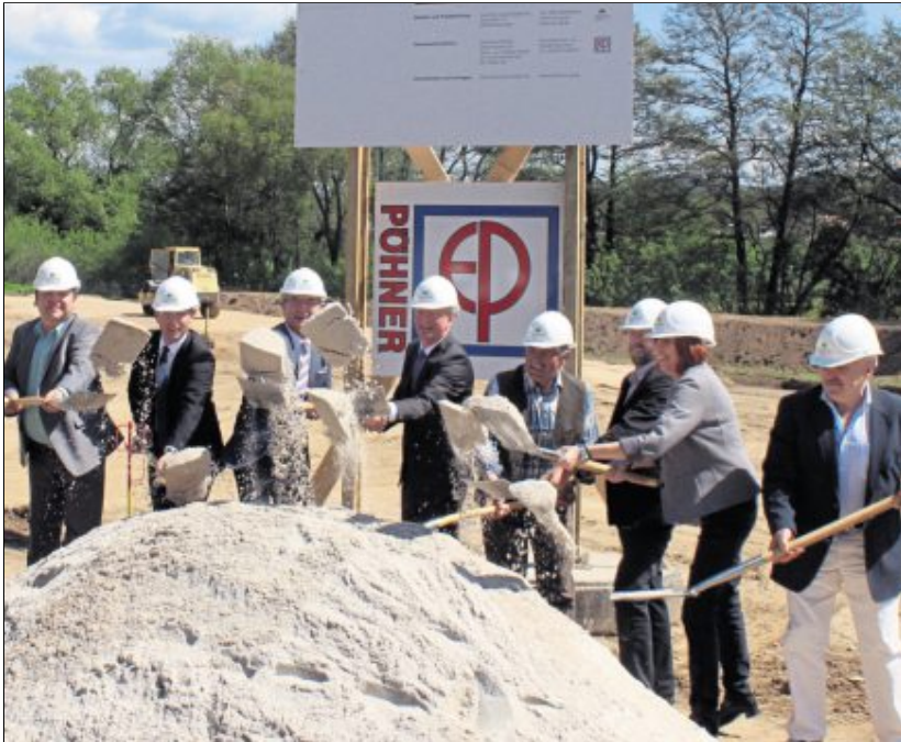
Die Verantwortlichen der SeniVita Social Estate AG sowie der Stadt Kemnath gaben am Dienstagmittag mit dem Spatenstich den Startschuss für die moderne Seniorenwohnanlage mit 48 Apartments. Bild: stg
